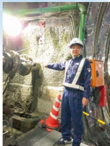
高速長尺先進ボーリング
