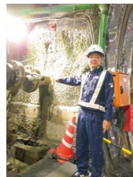
リニア工事現場(山梨県) 高速長尺先進ボーリング
