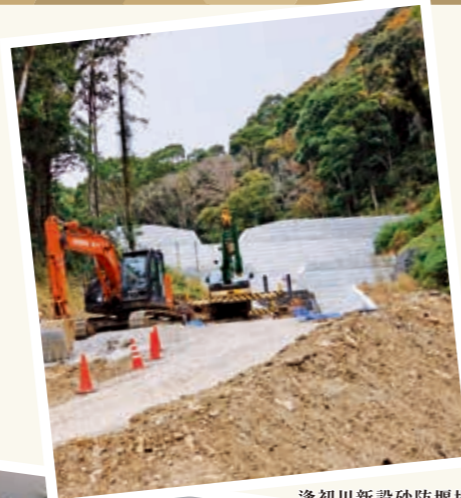
逢初川新設砂防堰堤
