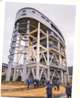
高知県黒潮町の避難タワー
