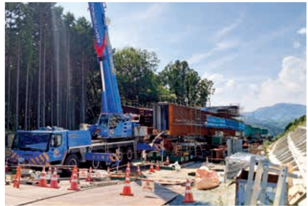
国道473号バイパス工事現場
